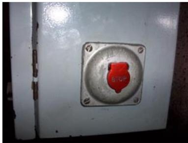
Figura 13, paradas de emergencia en cárcamo inferior.
